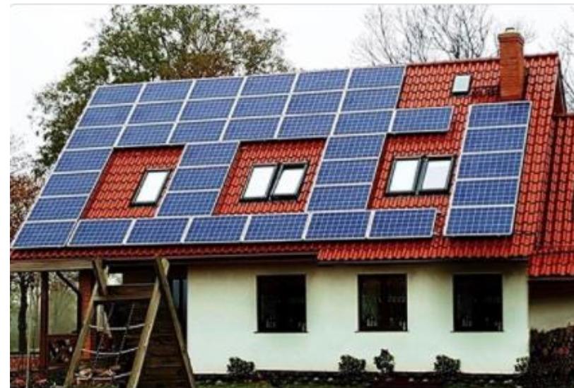
Instalacja fotowoltaiczna ~ 8300 kWh
